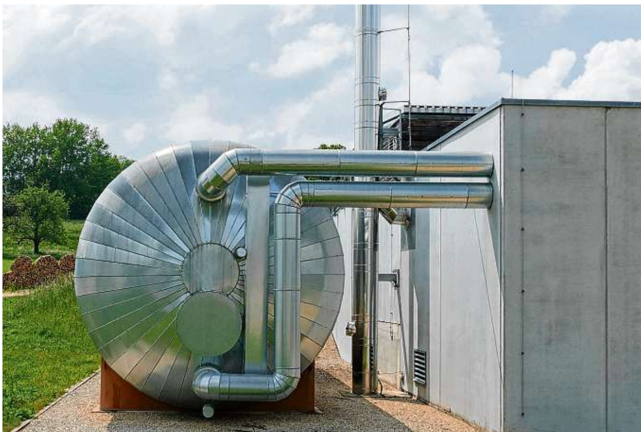
Ein Pufferspeicher, wie hier in Leibertingen, soll die Versorgungssicherheit für die Bezieher von Nahwärme erhöhen.
