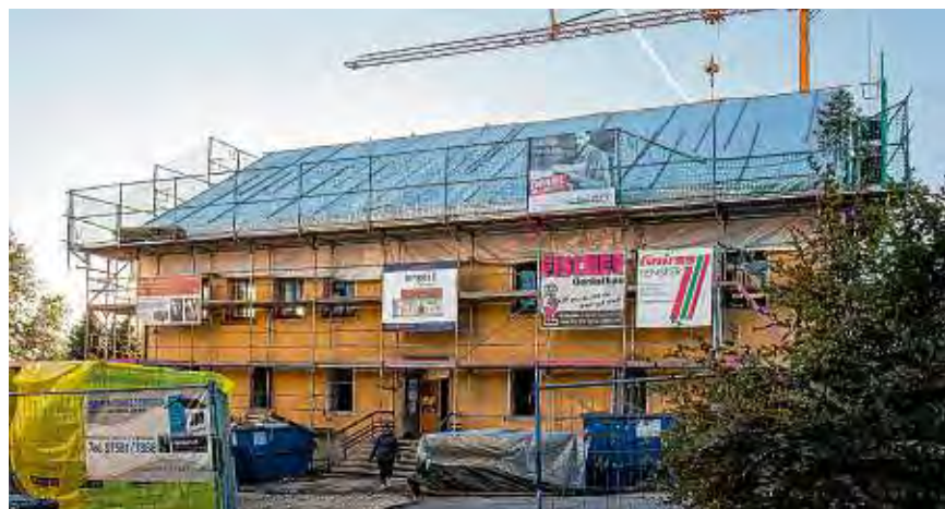
Noch präsentiert sich das ehemalige Thalheimer Rathaus als Rohbau. Wenn alles nach Plan geht, sollen in das Gebäude Ende 2020 die Vereine einziehen.
