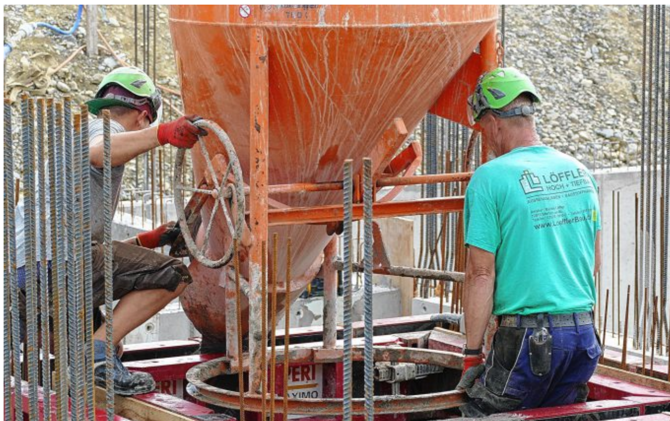
Beton wird auf einer Baustelle der Firma Löffler Hoch- und Tiefbau in Meßkirch gegossen. Er unterliegt gerade großen Preissteigerungen.
